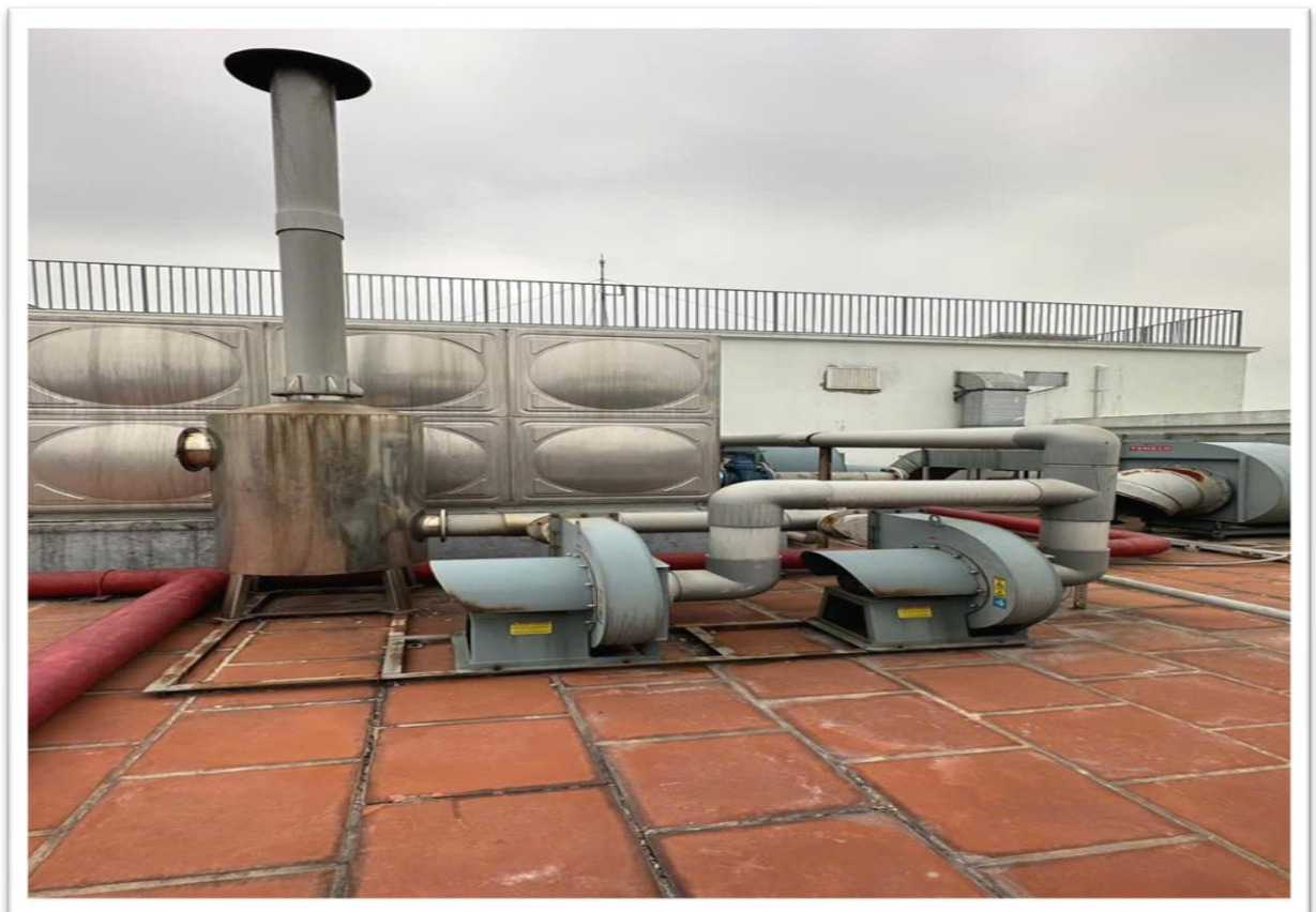
Hình 9. Hệ thống xử lý mùi hệ thống xử lý nước thải của cơ sở
